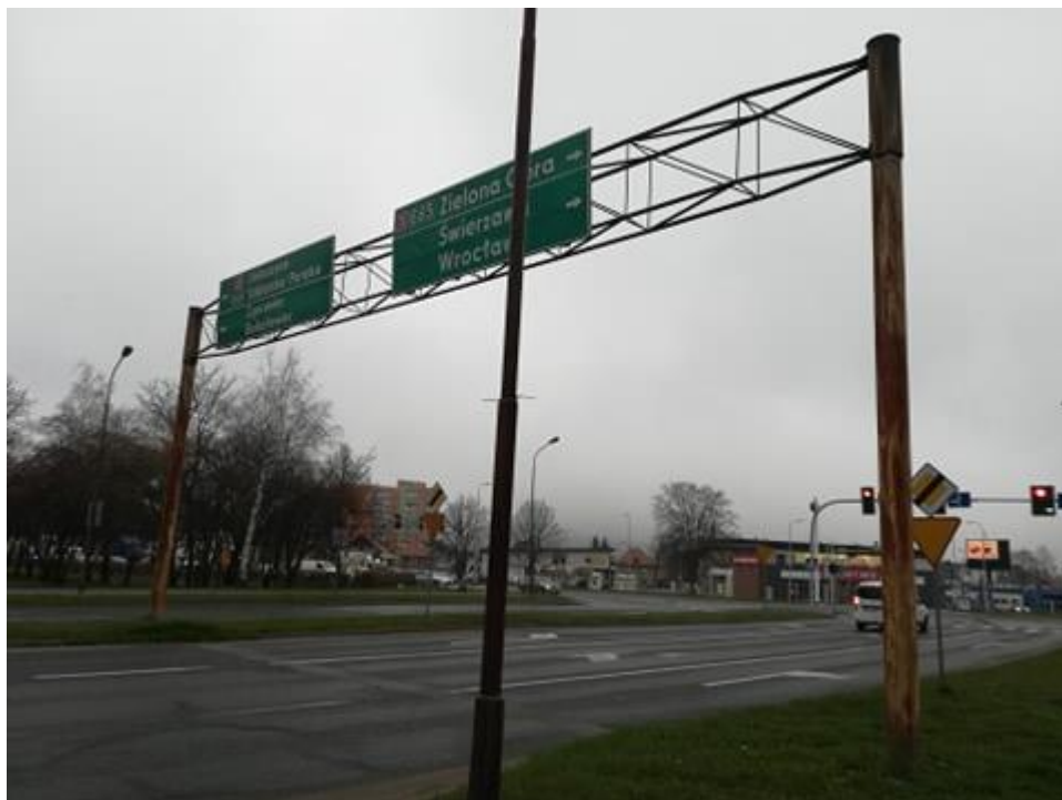
Fot. 3. Zdjęcie bramownicy z tablicami kierunkowymi E-2a – ul. Różyckiego.
