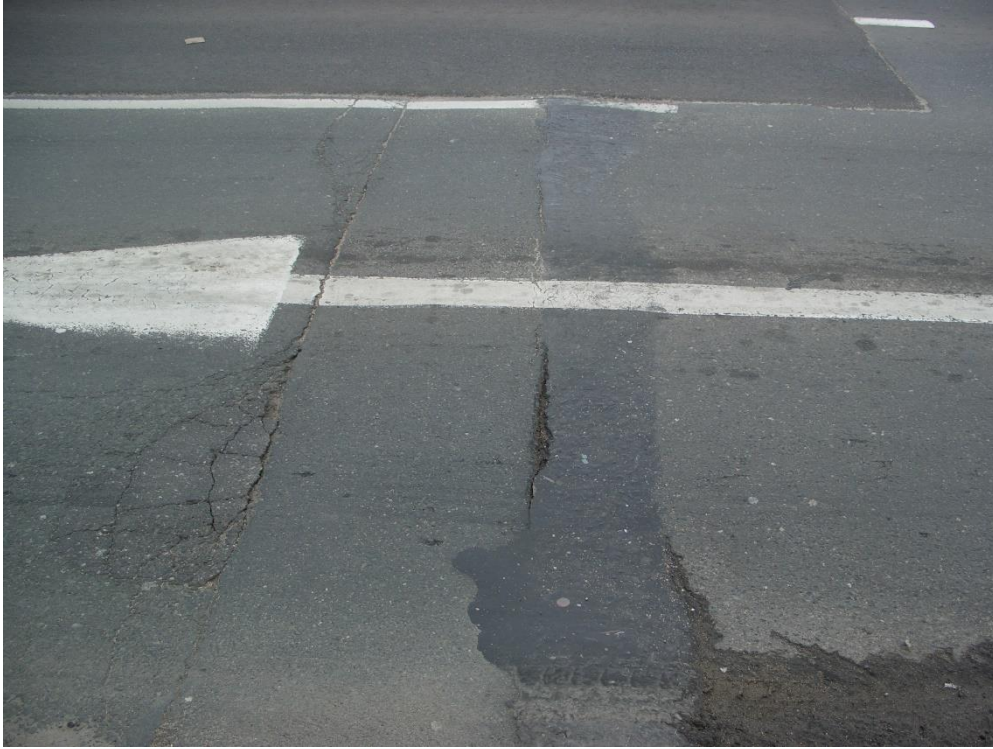
Zdj. 2.2. Widok przekrycia dylatacji.
