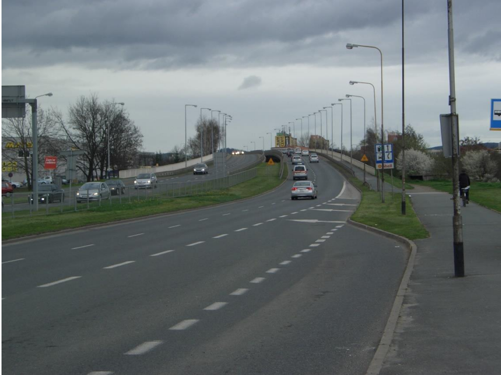
Zdj. 2.5. Widok na estakadę od strony ulicy Mostowej.
