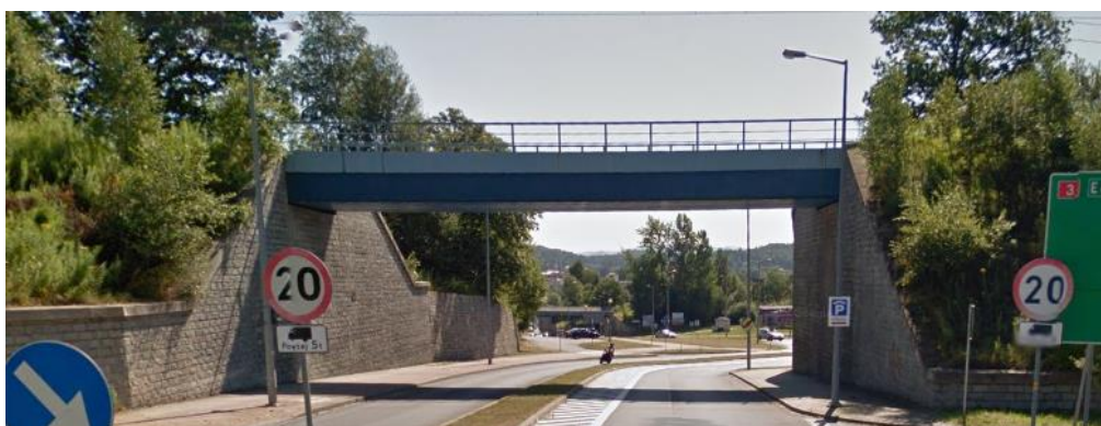
Zdj. 2.8. Widok na wiadukt kolejowy nad DK30.
