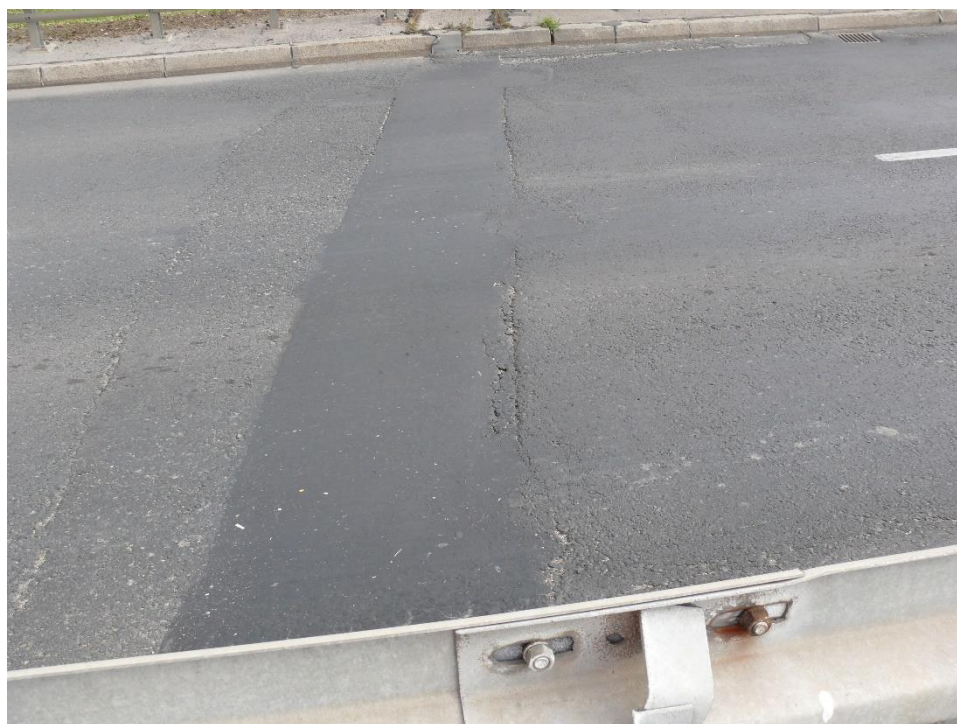
Zdj. 2.4. Urządzenie dylatacyjne.
