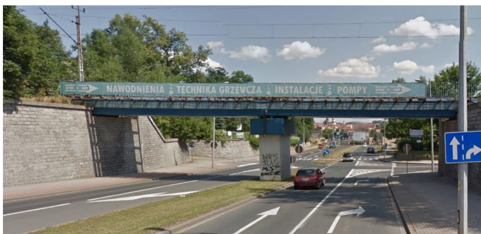
Zdj. 2.7. Widok na wiadukt kolejowy nad DK3.
