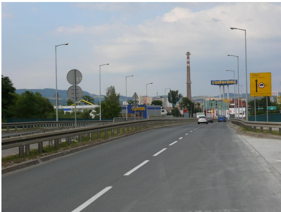
Zdj. 2.3. Widok na obiekt od strony ul. Jana III Sobieskiego.
