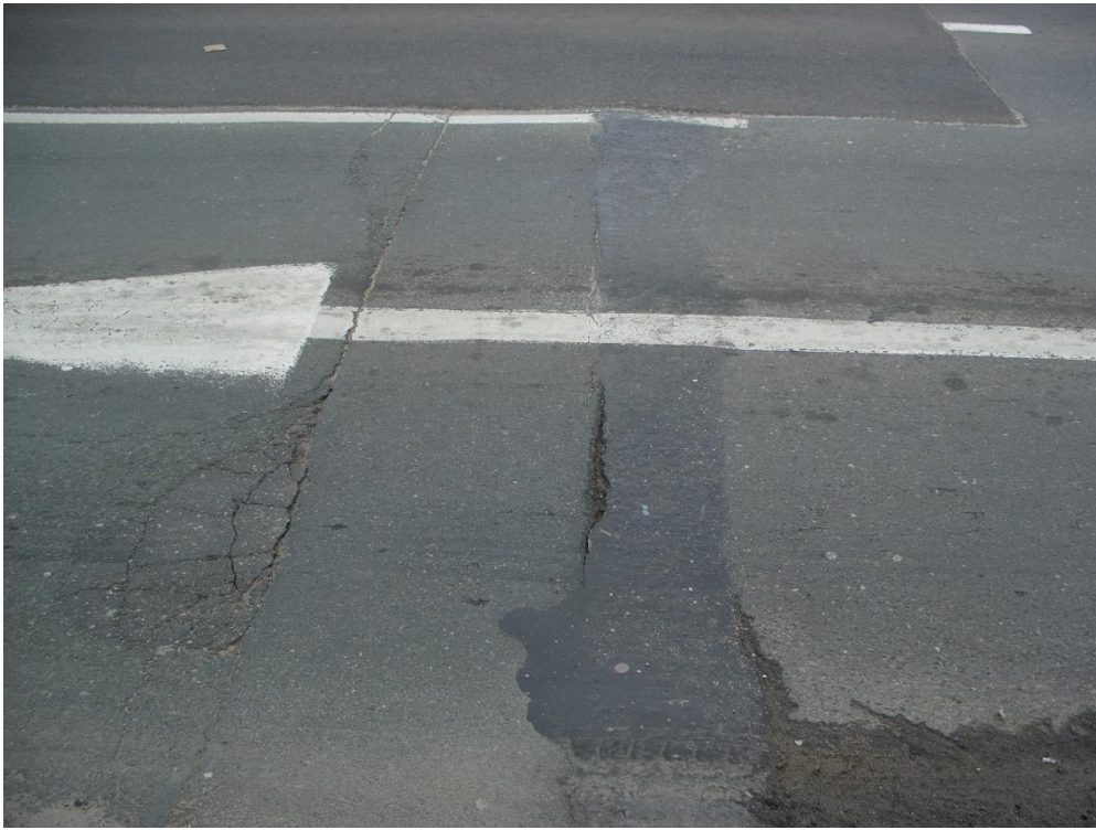
Zdj. 2.2. Widok przekrycia dylatacji.
