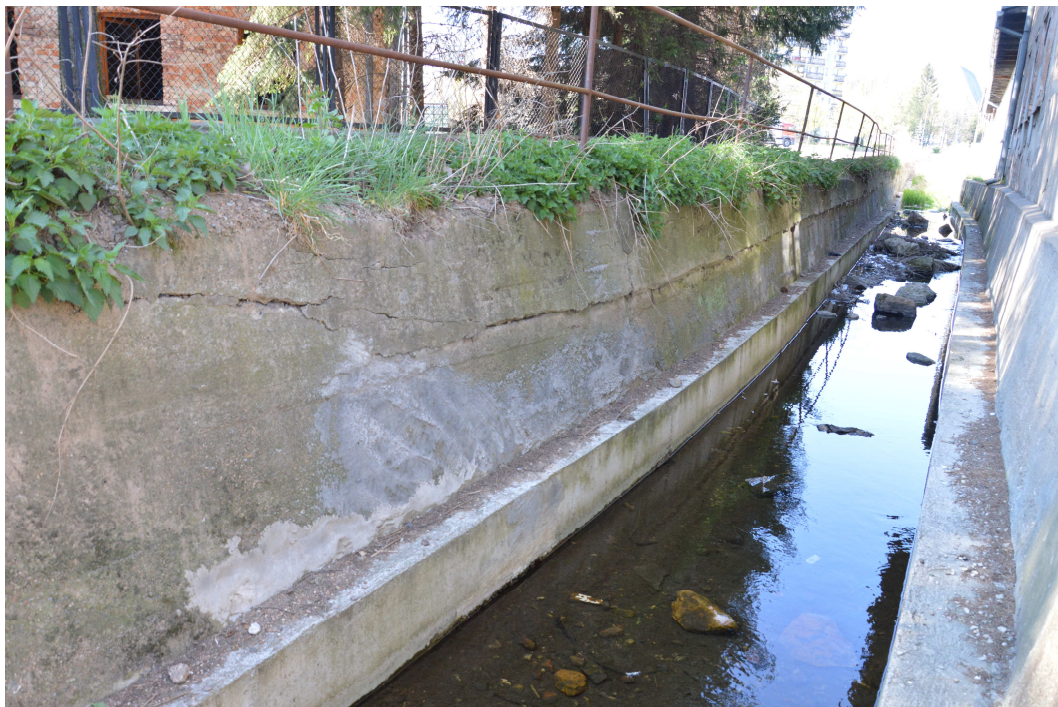
Fot. 2, 3 – Uszkodzenie korony muru betonowego
